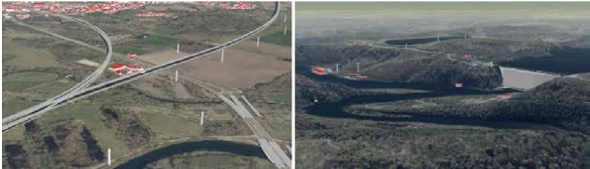
Abb. 17: ICE-Brückenbauwerk in der Saale-Elster-Aue in einer 3D-Modellierung. Dieser Teil der ICE-Strecke München-Berlin ist mit über 6 km Europas längste Fernbahnbrücke. Sie überspannt die besonders geschützte Auenlandschaft der Saale und Weißen Elster. Ebenfalls im Bild zu sehen ist eine parallel verlaufende Hochspannungsleitung. © GeoBasisDE/LVermGeo LSA, 2021.
